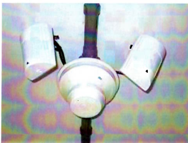
Figura nº 3 – Sensores de movimento e fumaça
