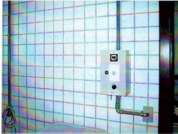
Figura nº 2 – Painel de controle dos sensores de presença e temperatura
